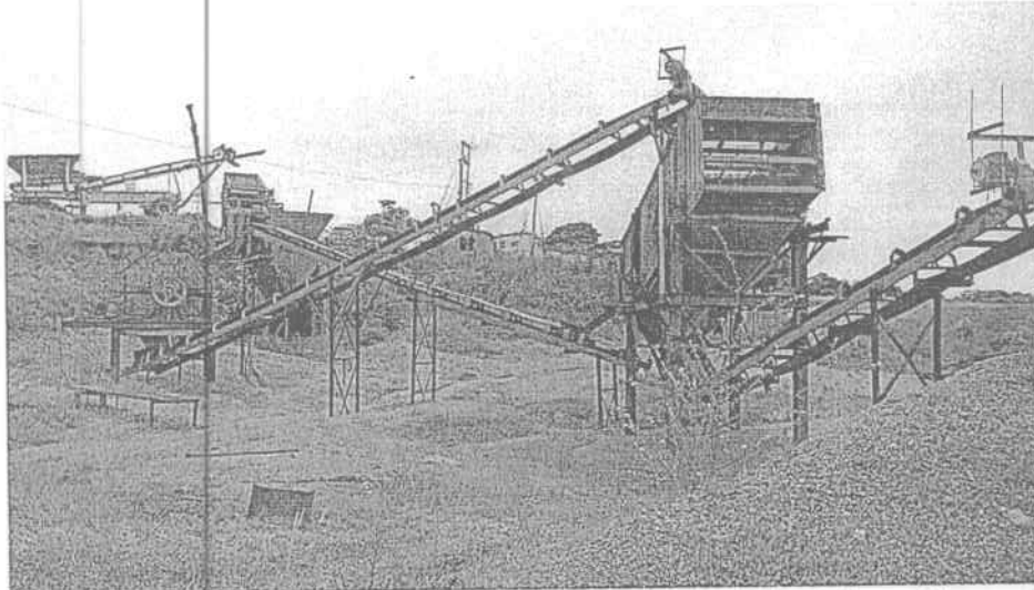
Fotografía No. 1 Planta Trituradora y clasificadora de materiales pétreos-Fuera de servicios por medida preventiva de suspensión de actividades.
